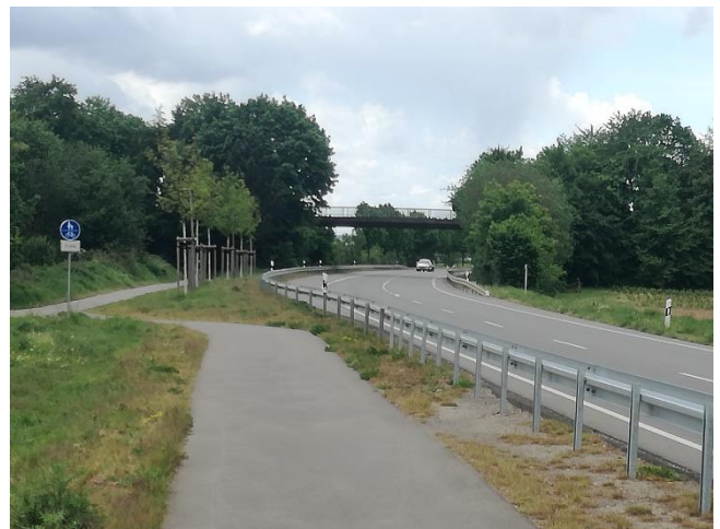
Zustand ab April 2020: Die verlängerte Leitplanke macht den Wechsel auf die Fahrbahn nun unmöglich – zweckmäßig wäre es, den Radweg unter der Brücke hindurch weiterzuführen.
