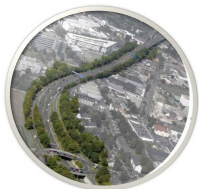
Noch säumt ein grünes Band den Tausendfüßler zwischen Enderich und Bonn-Nord © Strassen.NRW
