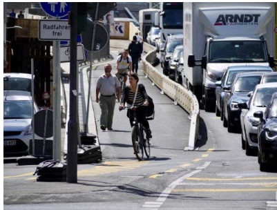
Baustelle Viktoriabrücke © Axel Mörer
