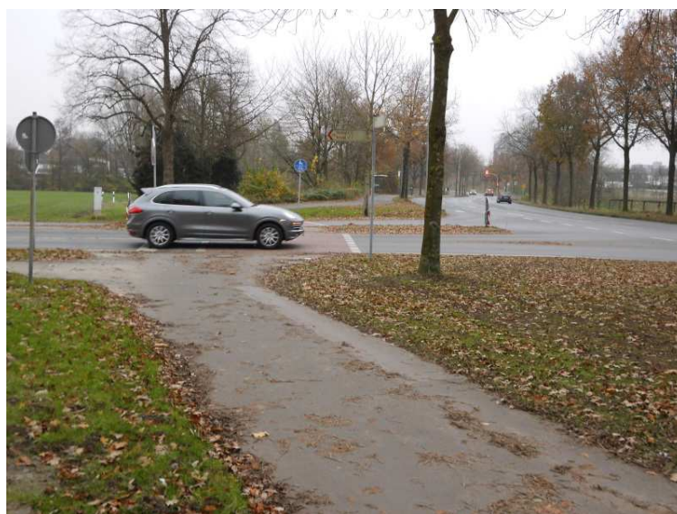
Abb. 8: Risikoreiche Querungen, hier an der Gievenbecker Reihe, gefährden Radfahrende auf dem Zweirichtungsradweg, insbesondere die zur „Geisterfahrt“ gezwungenen Radler
