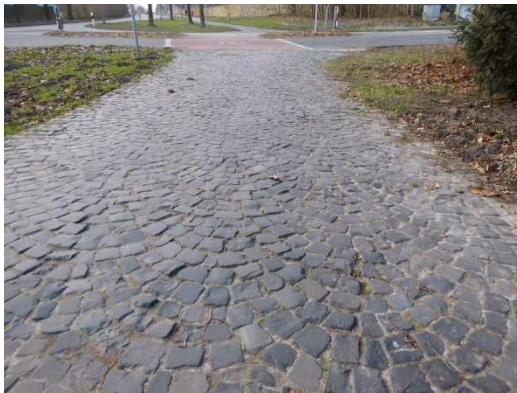
Abb. 10: Schlimmer geht's nimmer: Kopfsteinpflaster und Wurzelaufrüche auf dem Zweirichtungsradweg an der Roxeler Straße.
