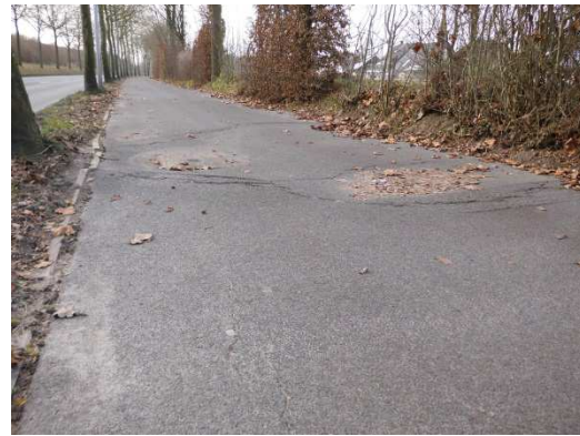
Abb. 10: Schlimmer geht's nimmer: Kopfsteinpflaster und Wurzelaufrüche auf dem Zweirichtungsradweg an der Roxeler Straße.
