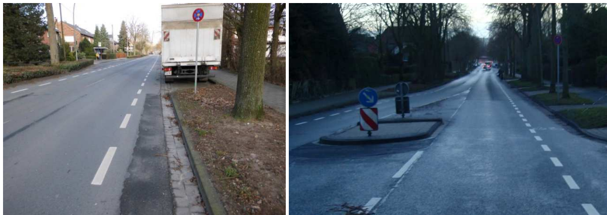
Abb. 3: Fahrzeuge verengen den ohnehin äußerst eng bemessenen Schutzstreifen an der Pienersallee zusätzlich. An den beiden Mittelinseln ragen Spiegel von passierenden LKW deutlich in den Schutzstreifen hinein; das ist brandgefährlich für Radfahrende, wenn Radfahrer und Fahrzeuge die Mittelinsel gleichzeitig passieren.
